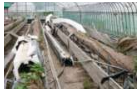
いちごハウス高設ベンチ倒壊
